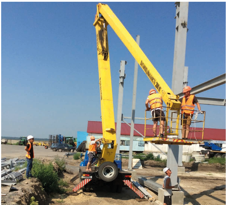
На будівництві механічної майстерні.
