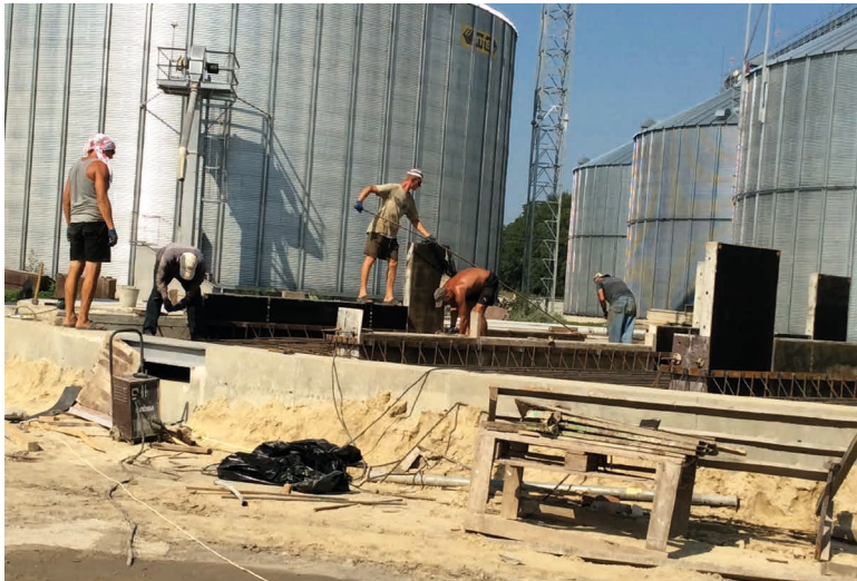
Бригада бетонярів монтує фундамент під силоси.
