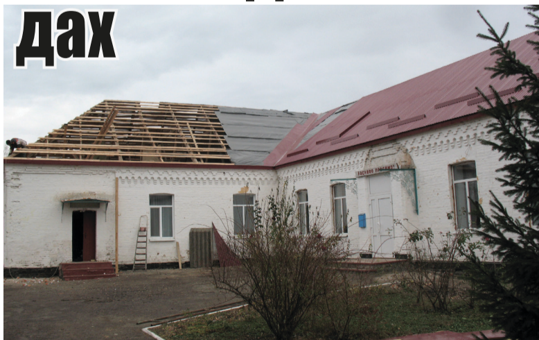
Ремонтні роботи в Красногорівській ЗОШ.
