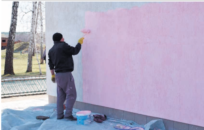
Будівельники фарбують фасад НВК.
