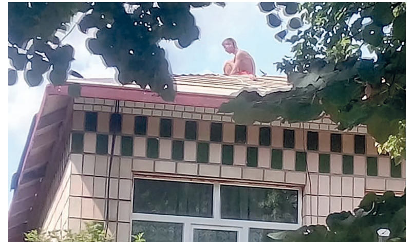
Ремонт даху Балаклієвського НВК.
