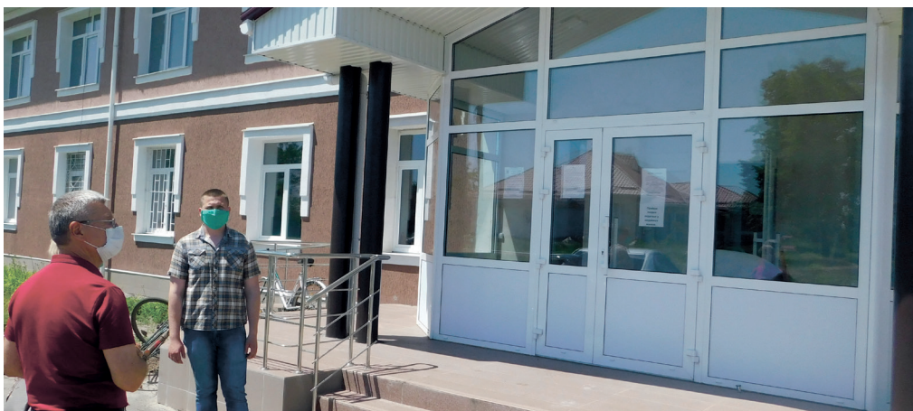
У Білоцерківській амбулаторії загальної практики–сімейної медицини тривають ремонтні роботи.
